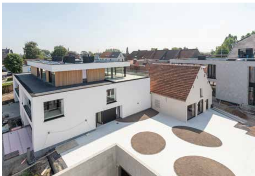
De gevels bestaan uit een witte crepi met accenten uit duurzaam ecologisch hout.
