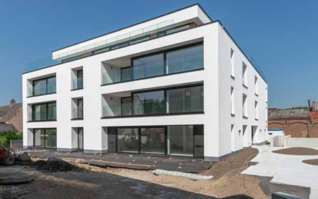
Achter het oude postkantoor zijn twee nieuwe woonblokken gebouwd.
