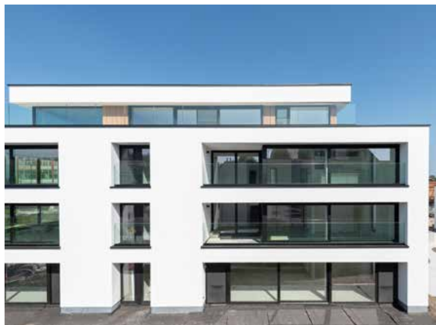
Het zwartgelakt aluminium schrijnwerk maakt het visuele plaatje compleet.
